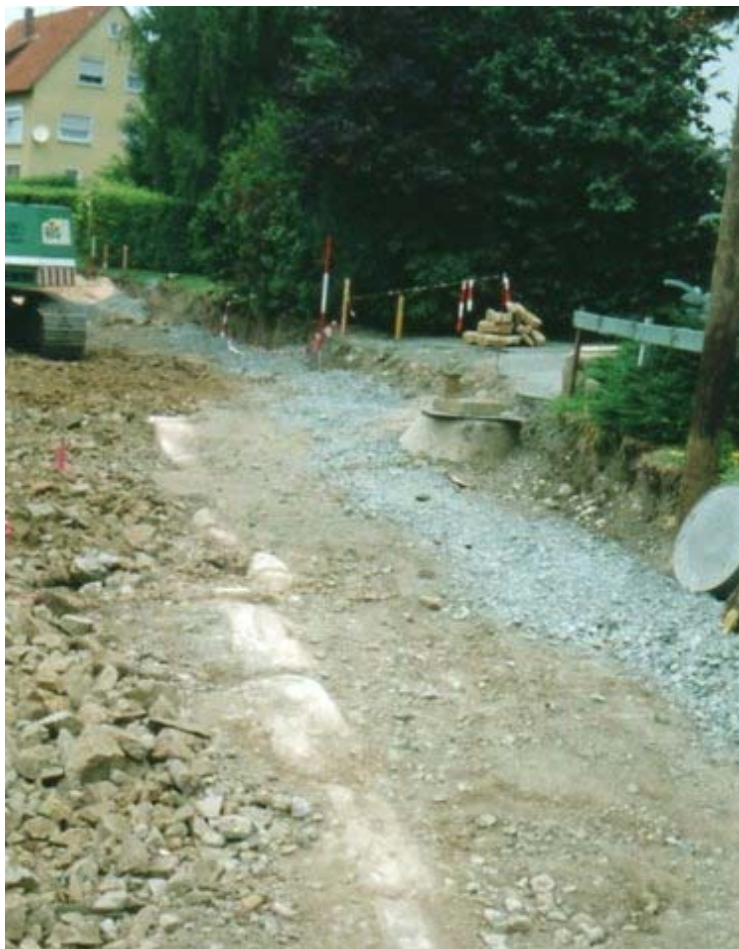
Abb.: Befestigungen von früher in der Maintalstraße (1994).
