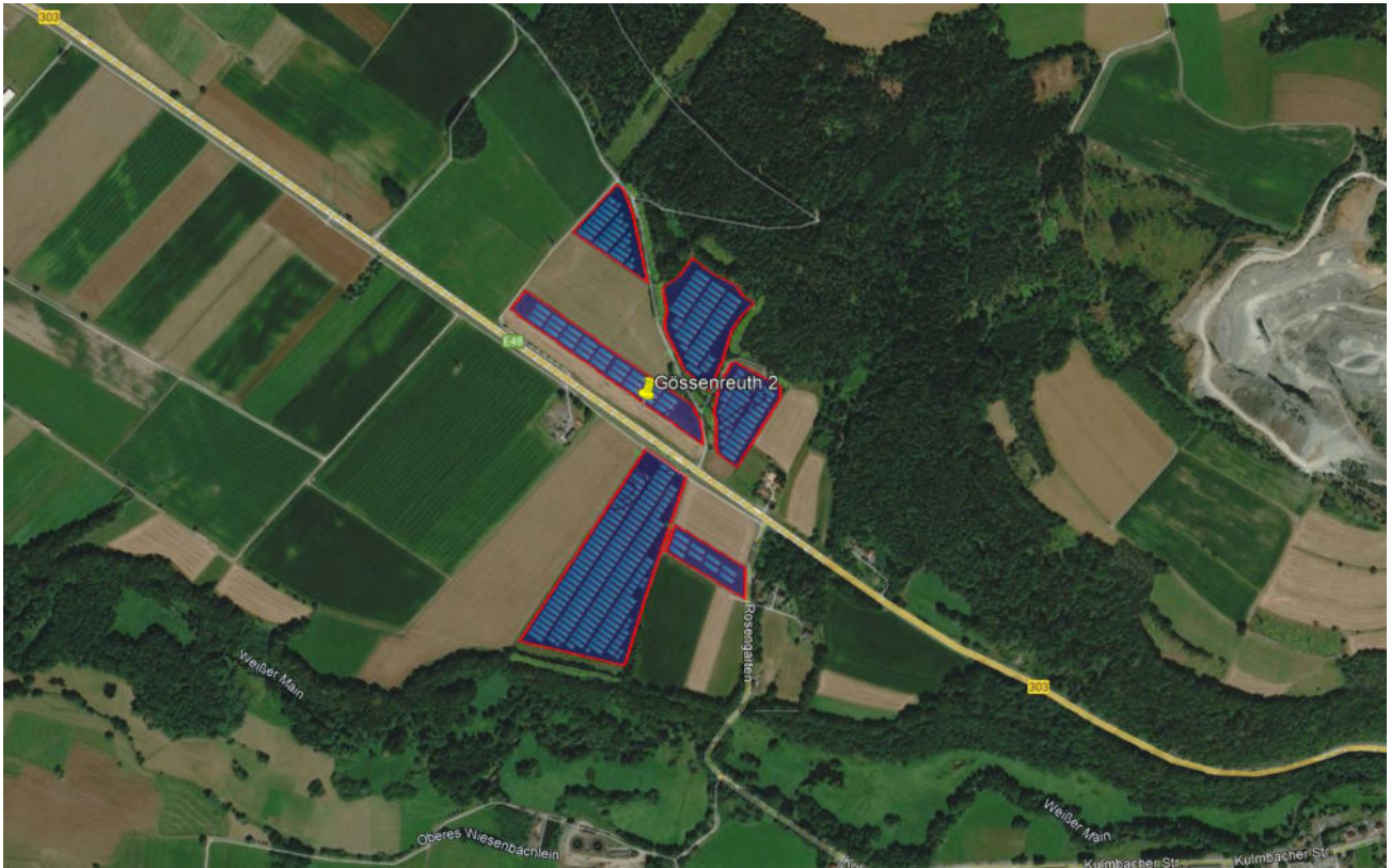
Bild 2.1.2: Detailansicht der PV-Flächen (Quelle: Google Earth/SolPEG)
