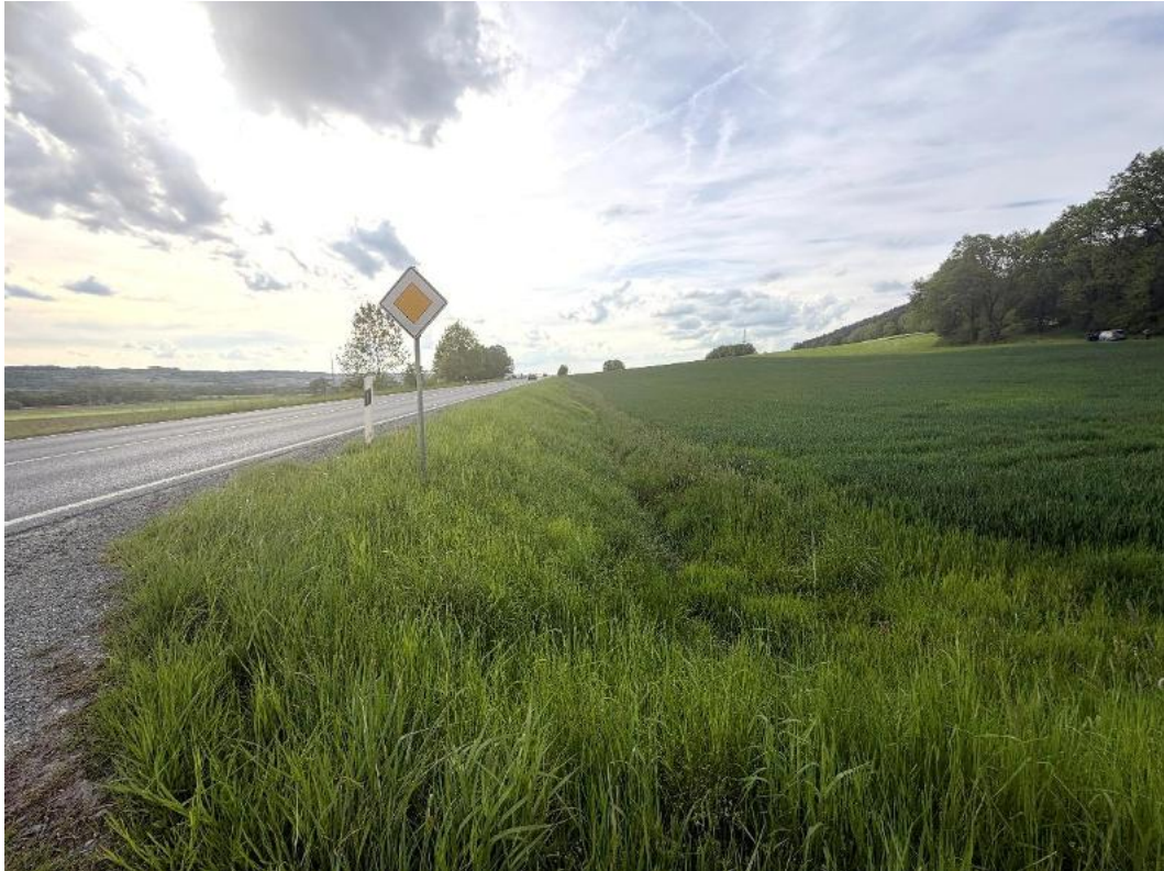
Bild 3: Graben entlang der Bundesstraße, hier Bereich südlich Feld 4.
